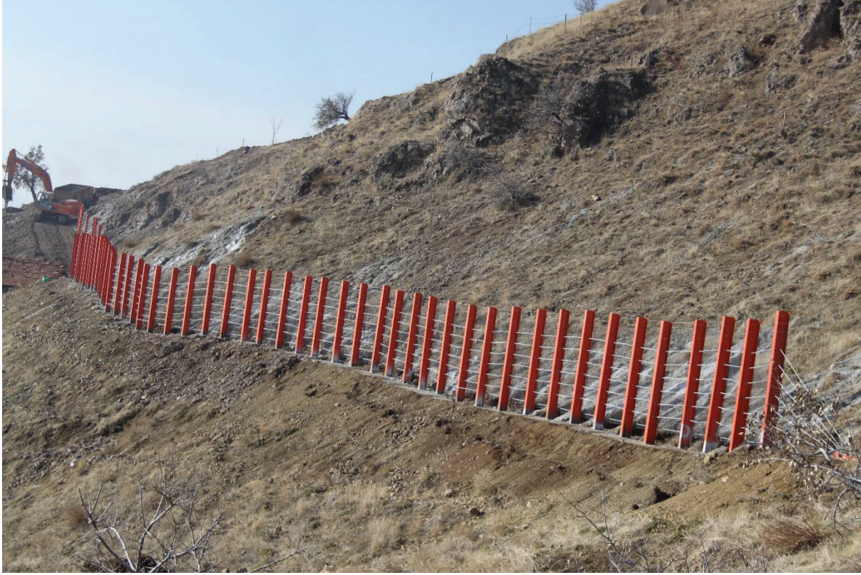
Şekil 1.27. Bayat İlçesi Pancarlık Köyünde yapılan kaya ıslah çalışması
